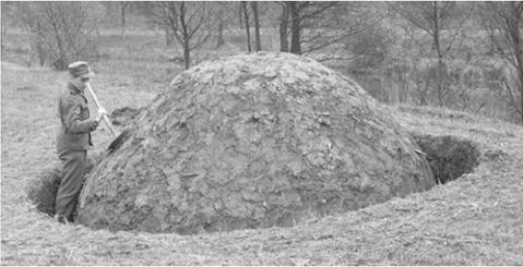
**Bild 1:** Der frei geformte Hügel als Schalung für einen Beton-Iglu | **Fig. 1:** The freely shaped hill as formwork for a concrete igloo
