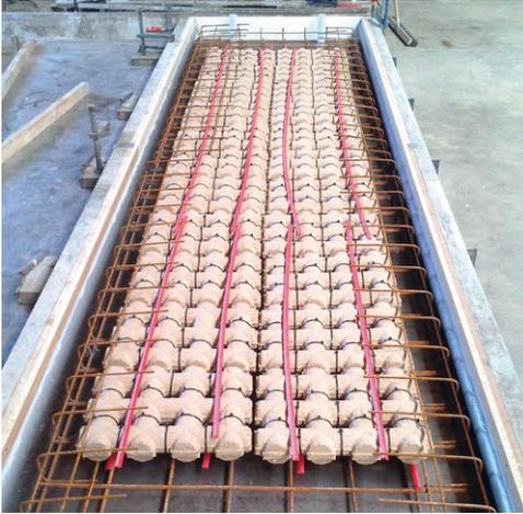
**Bild 10:** Platte mit Verdrängungskörper, Betonstahl, Abspannhülsen, Auftriebsicherung | **Fig. 10:** Slab with displacement body, reinforcing steel, bracing sleeves, uplift protection
