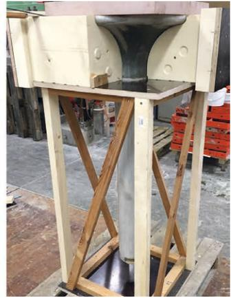
**Bild 3:** Schalungskonzept und Betonage der Stützelemente | **Fig. 3:** Formwork concept and concreting of column elements | Source: Jeldrik Mainka
