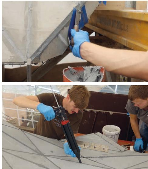
Bild 9: Einbringen des Mörtels in die Faltkante: händischer Einbau (oben) und Einbau mit Mörtelspritze (unten) | Fig. 9: Pouring of grout into folding edges: manual installation (top) and installation with mortar caulking gun (bottom)
