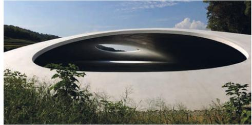
**Bild 2:** Teshima Art Museum, 2010; die Schalung aus Sand wurde durch die elliptische Öffnung ausgehoben | **Fig. 2:** Teshima Art Museum, 2010; the formwork made of sand was excavated through the elliptic opening
