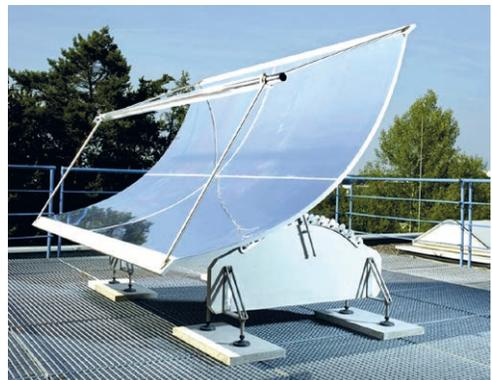
**Bild 1:** Demonstrator aus Hochleistungsbeton an der TU Kaiserslautern | Quelle: Thomas Brenner
