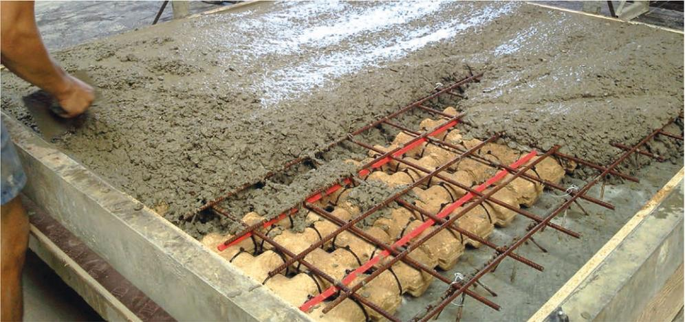
Bild 12: Betoneinbau | Fig. 12: Concrete placing
