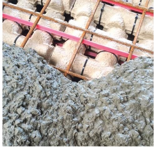
**Bild 11:** Größenverhältnis Frischbeton – Geometrie Verdrängungskörper | **Fig. 11:** Size ratio fresh concrete – geometry displacement body
