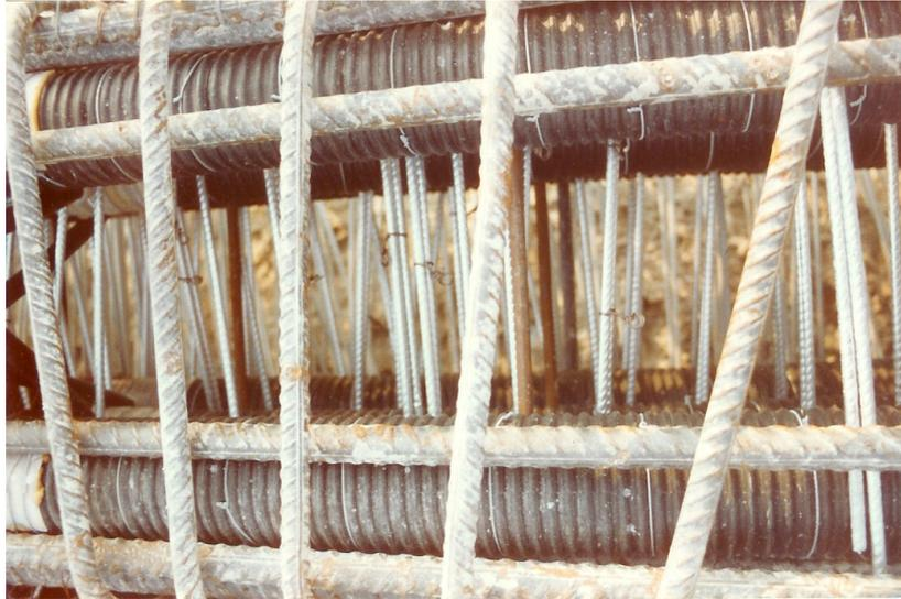
*Abb. 3.B.6 Draufsicht auf den Mittelträger, nachdem die herausgerissenen Längsvorspannungskabel wieder in die gerechnete Lage gebracht waren, sowie die Querverdübelung eingelegt war.*
