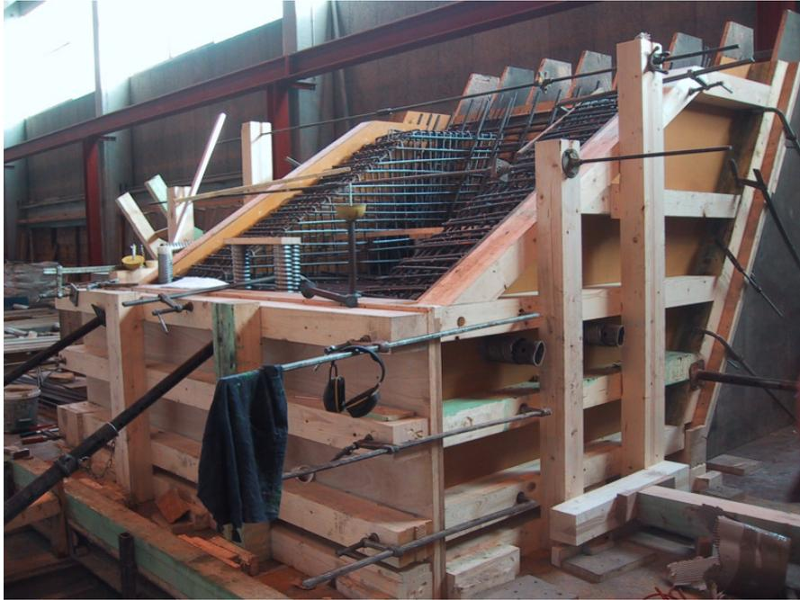
Abb.7.B.8 Vorbereitungen und Herstellung des Brückenmodells im Mstb 1:1
