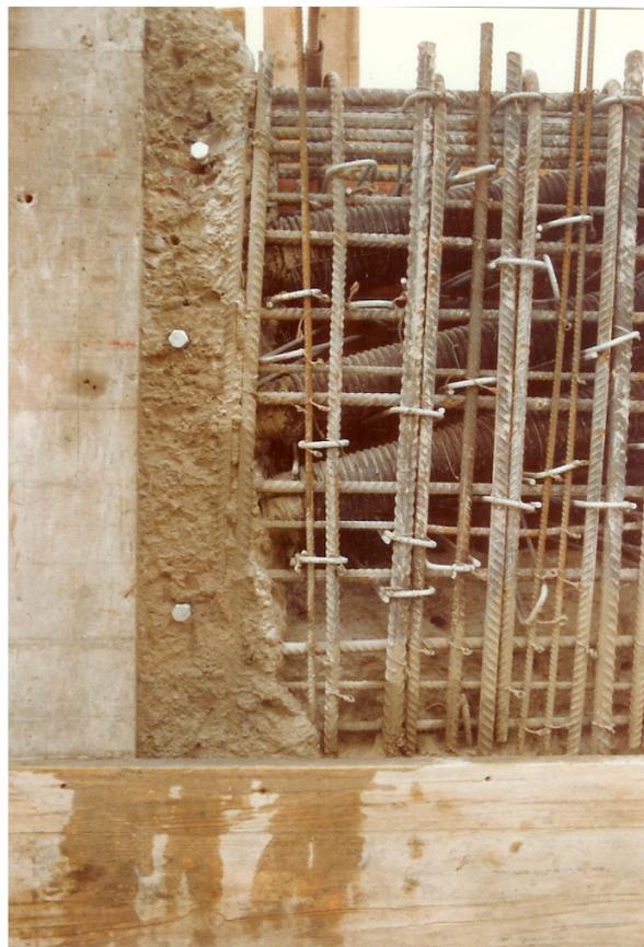
*Abb.3.B.5 Freigelegter Mittelträger nach dem Bruch*
